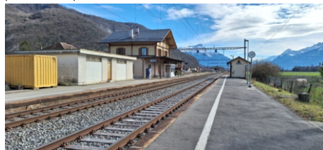
Vue avant travaux photo © SBB CFF FFS
