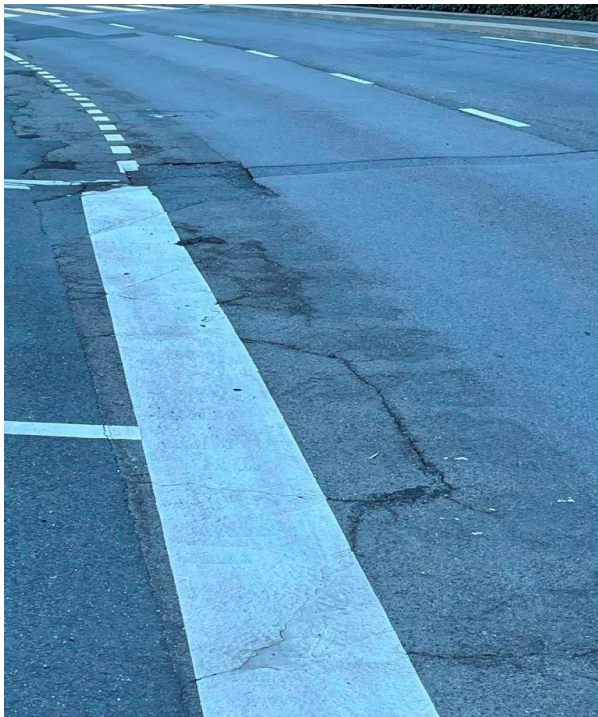
Chaussée au droit du carrefour Montjoux sur RC780
