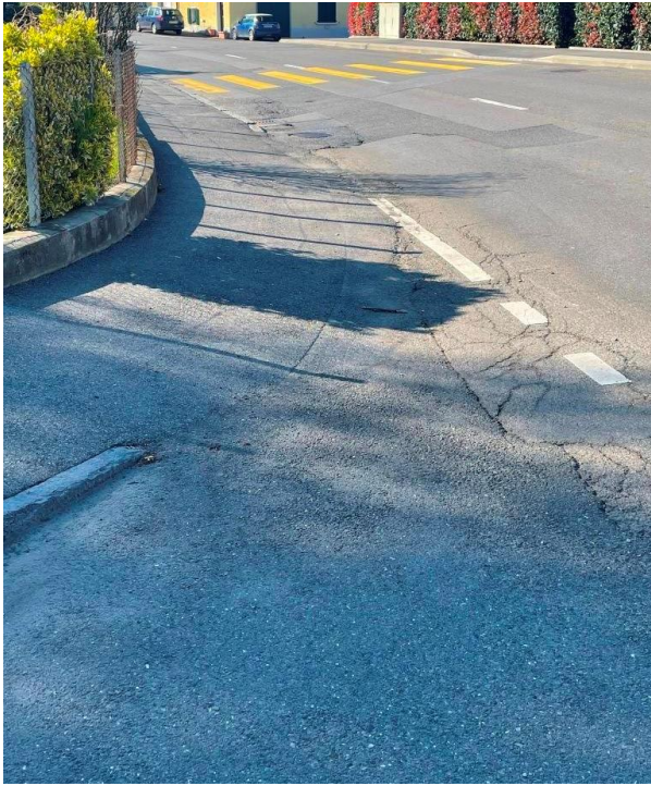
Trottoir au droit du carrefour Montjoux sur RC780
