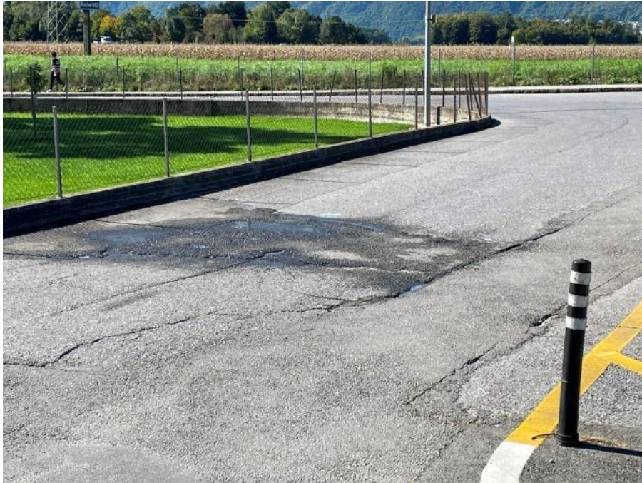
Chaussée à hauteur de la Gare sur la rue de la Gare
