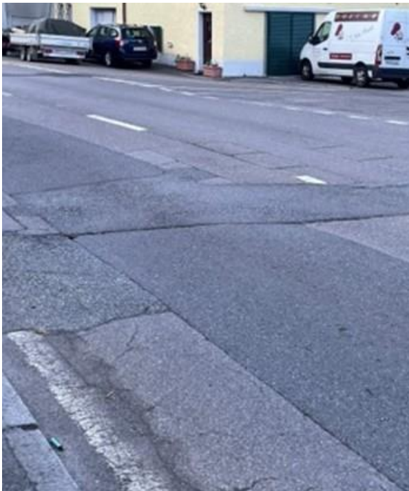
Chaussée au droit du carrefour rue de la Gare sur RC780
