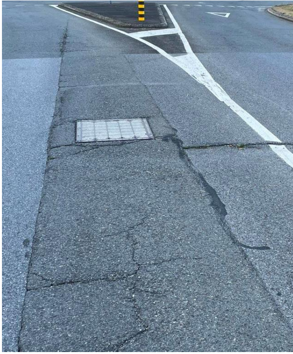
Chaussée au droit du giratoire « SODIROCHE » sur RC780
