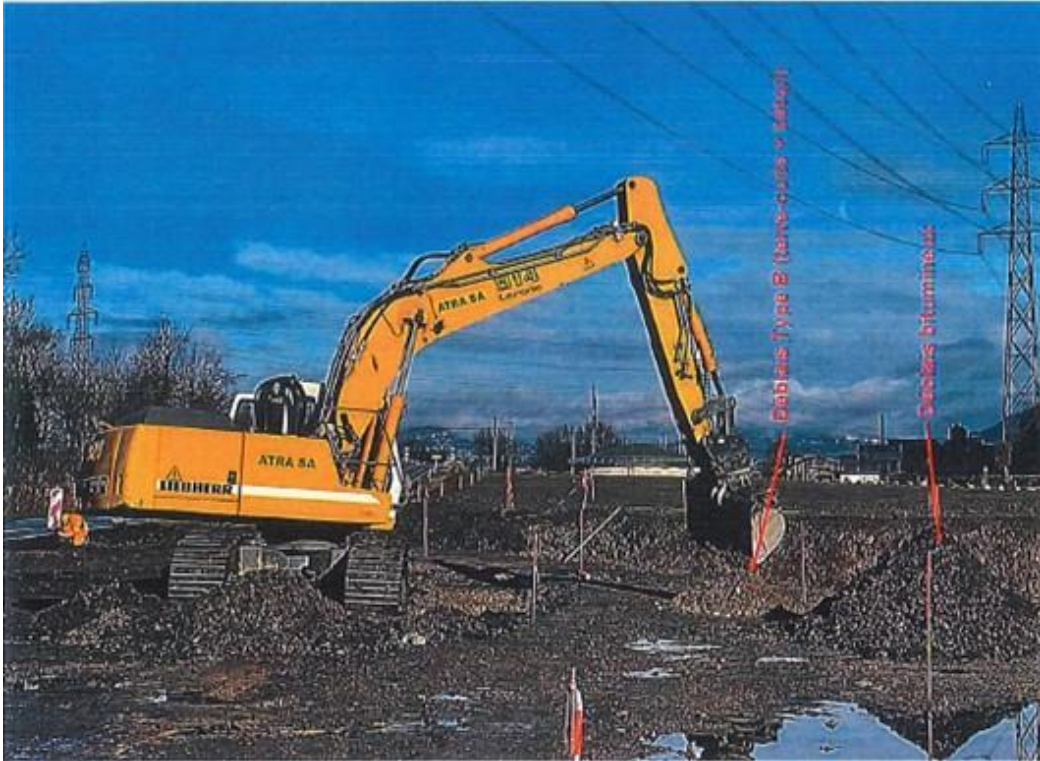
Tri déchets terre-cuite et béton + matériaux bitumineux
